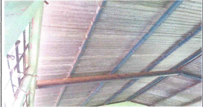
Foto 4: Cambio Costaneras, Tijeras y Vigas.
