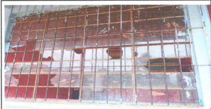
Foto 6: Cambio de Ventana y Vidrio.
