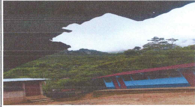
Foto 2: Cambio de Techo.
